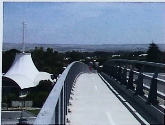
El puente peatonal que va de la isla de Hindmarsh a Australia del Sur.
