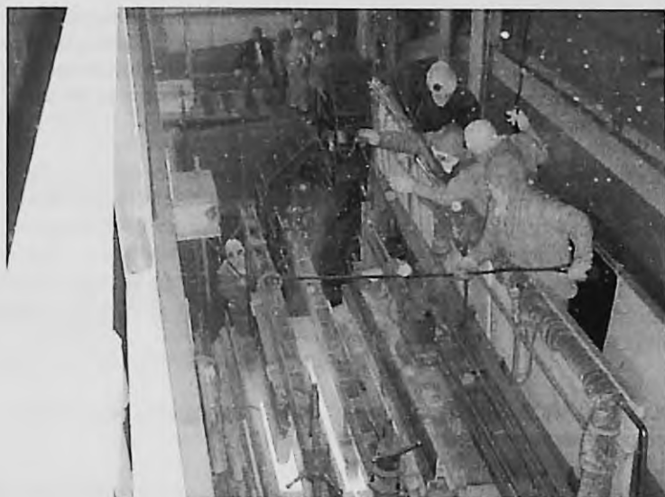
Figura 1.3. Cuando se trabaja con fuego, hay que optimizar los equipos de seguridad
