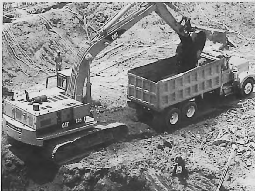
Figura 5.3. Los trabajos con maquinaria pesada requieren a personal capacitado
